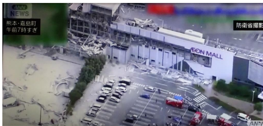
イオンモール熊本のガス爆発事故 最上階の2階の外壁が吹き飛ばされ7名が死亡した
